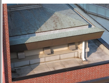
屋根・屋上：良好
